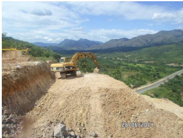
K99+500 Adecuación terrazas talud Roca del lancero
