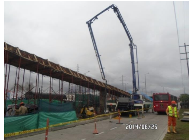
Construcción viga cajón, puente peatonal San Mateo
