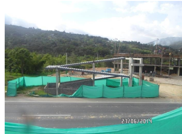
K48+450 Estado actual puente peatonal Balcones del Bosque
