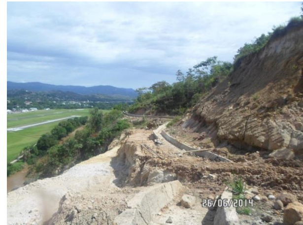
K99+500 Construcción cunetas de coronación talud Roca del lancero
