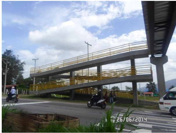
K51+500 Construcción rampas y pila central puente peatonal Tibacuy
