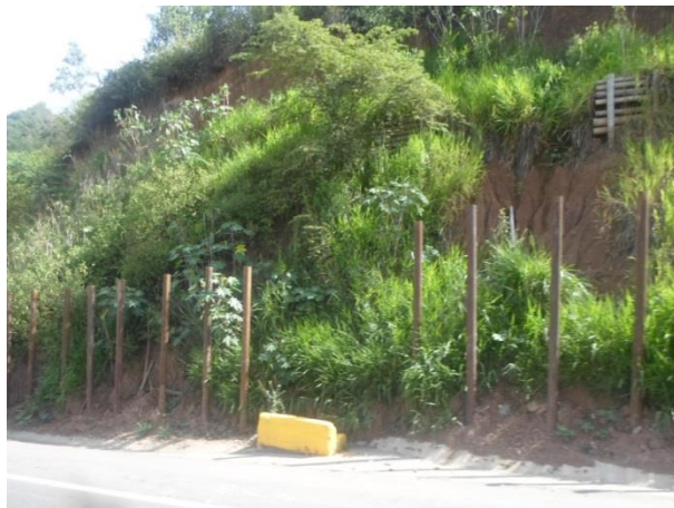
K82+500 Instalación de tubos metálicos para construcción de pantallas
