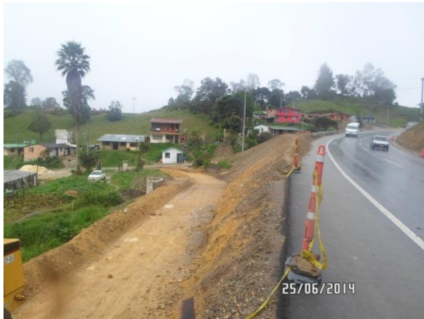
K34+150 Construcción vía para acceso veredal
