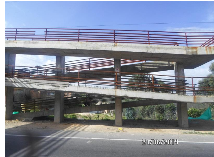
K20+900 Conformación de separador central en tierra
