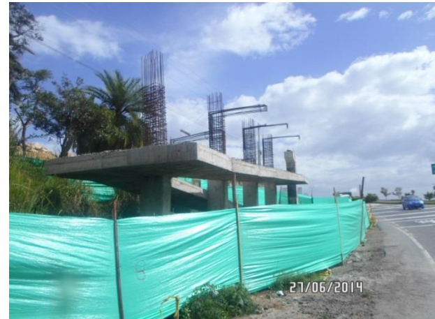
K51+500 Construcción rampas y pila central puente peatonal Tibacuy
