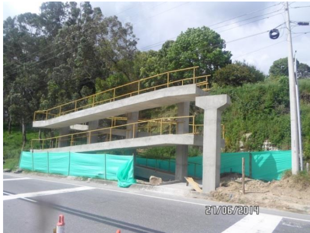
K51+500 Construcción rampas y pila central puente peatonal Tibacuy
