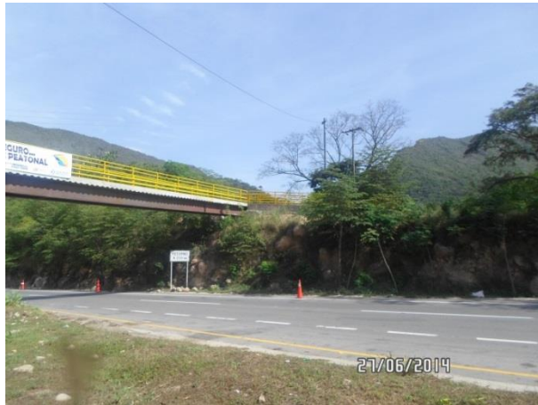
Estado actual puente peatonal Boquerón K85+200
