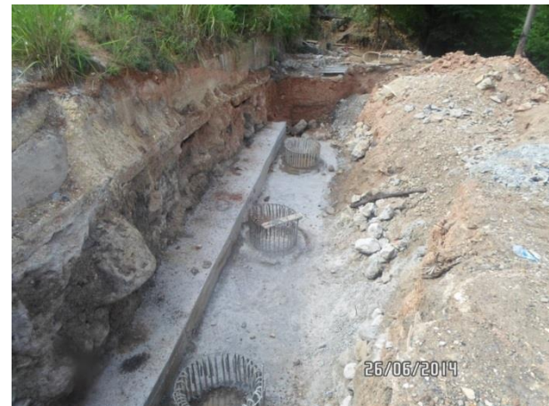
K83+530 Fundida de caissons para construcción muro de contención
