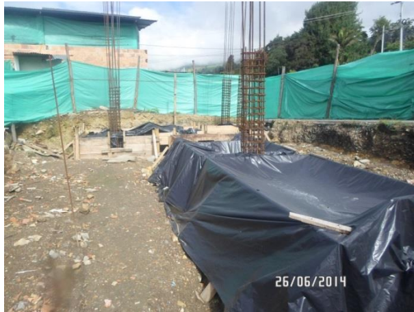
K29+400 Construcción pila costado izquierdo puente peatonal de santa Lucia
