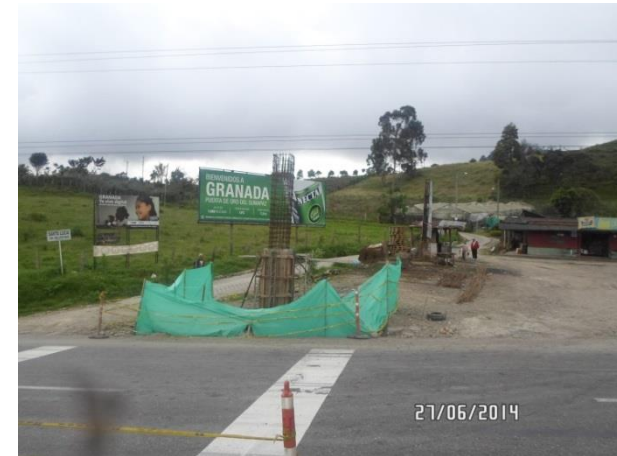
K29+400 Construcción pila costado izquierdo puente peatonal de santa Lucia
