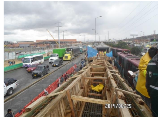
Construcción viga cajón, puente peatonal San Mateo
