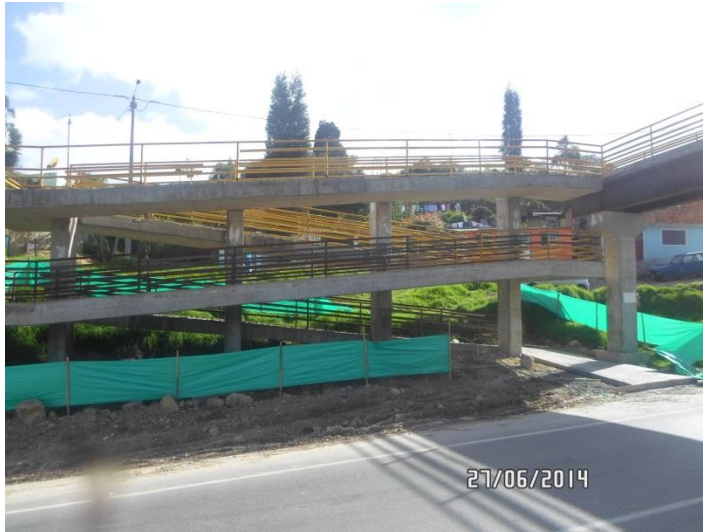
K20+980 Estado actual, puente peatonal Alto de la Cruz
