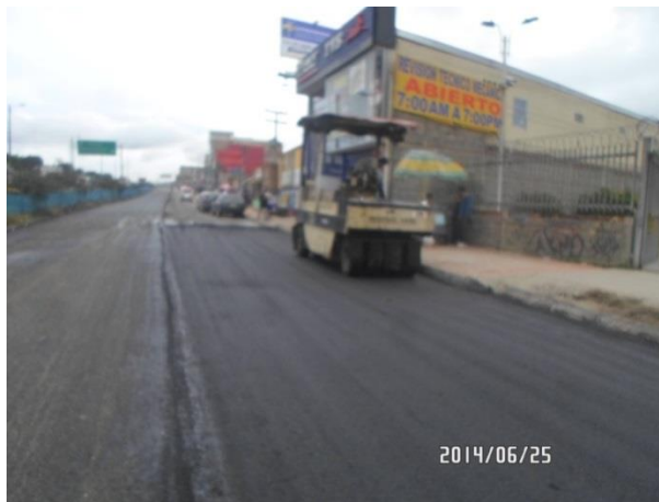
Colocación de mezcla asfáltica, rehabilitación paralela norte
