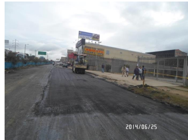
Colocación de mezcla asfáltica, rehabilitación paralela norte
