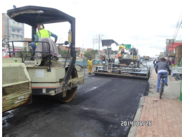
Colocación de mezcla asfáltica, rehabilitación paralela norte
