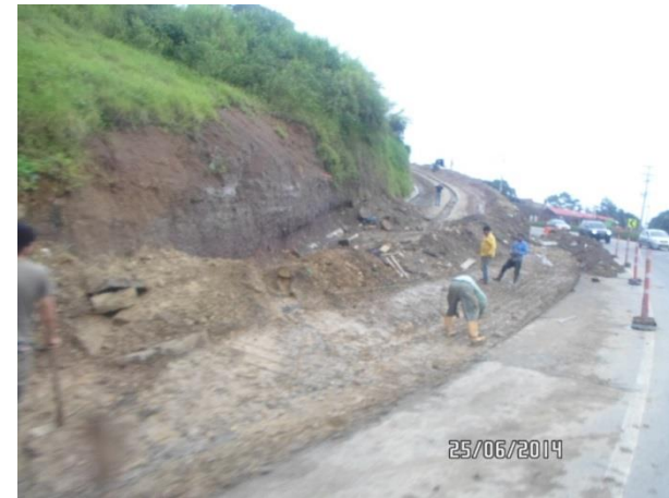
K45+800 Construcción vía para acceso veredal
