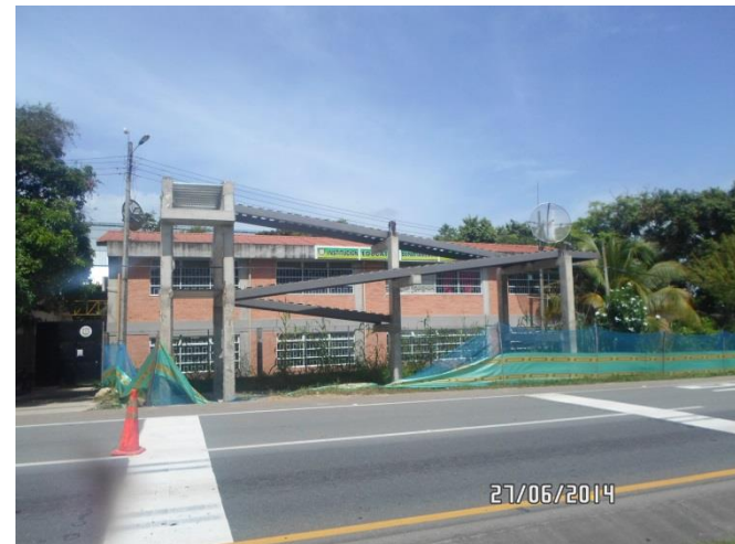
PR18+130 Estado actual, costado derecho puente peatonal La Esmeralda
