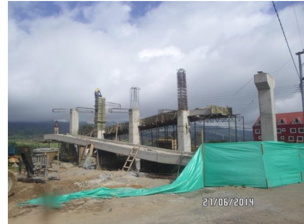
K32+240 Construcción rampas 1 y 2 costado izquierdo puente peatonal La 22
