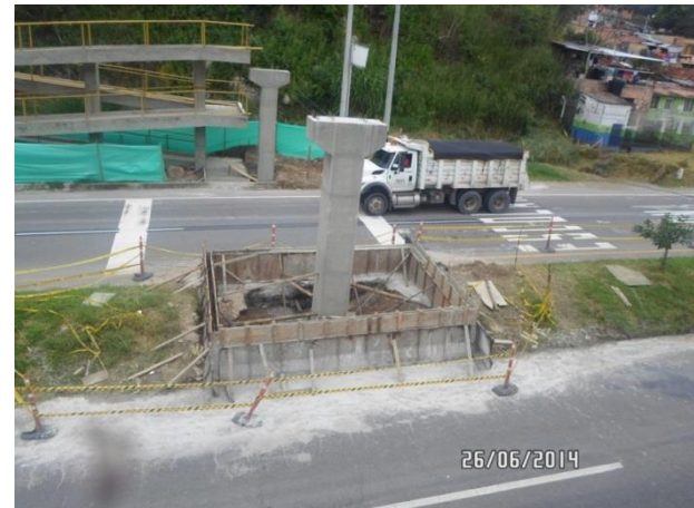
K51+500 Construcción rampas y pila central puente peatonal Tibacuy
