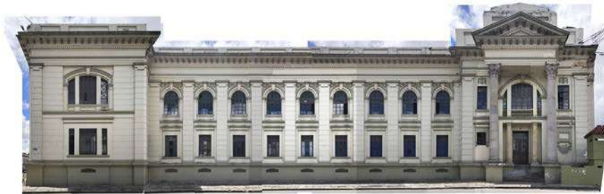
Figura 76: Fotografía fachada sur.
