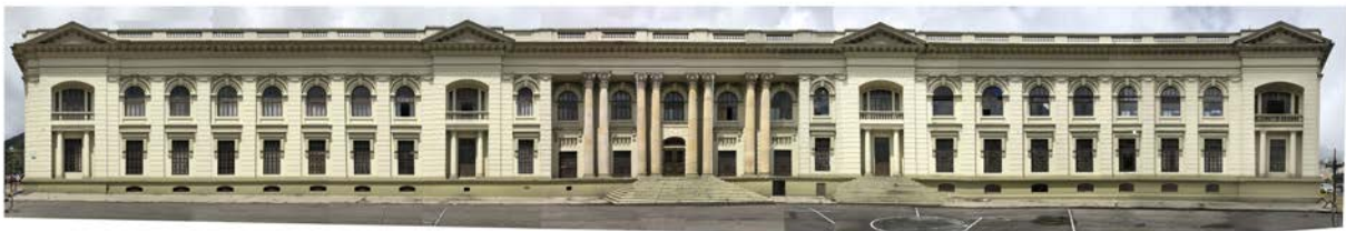
Figura 61: Fotografía fachada occidental.
