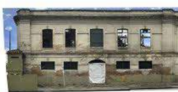
Figura 92: Cuerpo sur fachada oriental edificio "La Flauta" Fuente: Fotografía Consultoría NVP arquitectos 2018.
