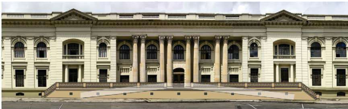
Acceso costado Occidental del Batallón de Reclutamiento
