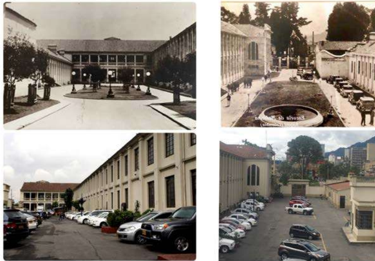
Figuras 82, 83, 84 y 85: Fotografías antes y después parqueadero y fachada occidental.
