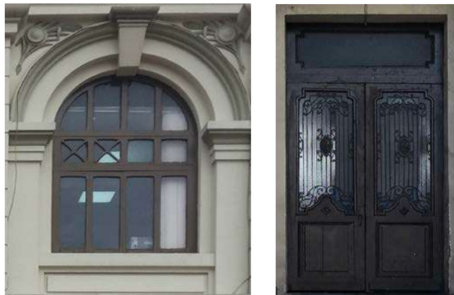
Figuras 124 y 125: Carpintería en madera – Ventana fachada Calle 15- Puerta Principal Calle 9. Fuente: Fotografías consultoría NVP arquitectos 2018.
