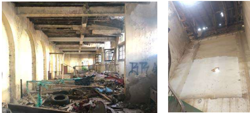
Figuras 130 y 131: Muro posterior occidental, primer piso. - Muro posterior occidental, segundo piso. Fuente: Fotografía consultoría NVP arquitectos 2018.
