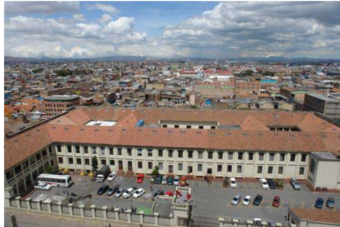
Figuras 144 y 145: Cubierta interior y exterior.
