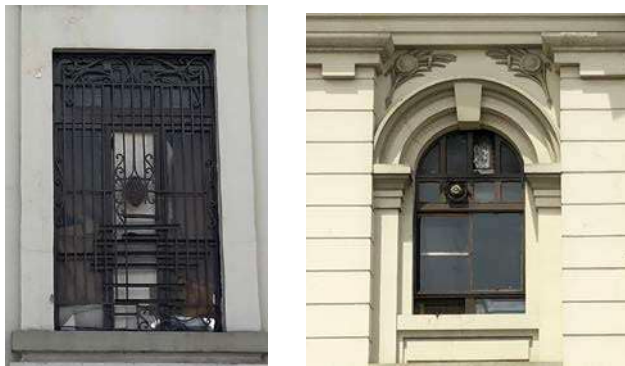
Figuras 150 y 151: Ventana fachada sur. Ventana fachada occidental. Fuente: Fotografías consultoría NVP arquitectos 2018
