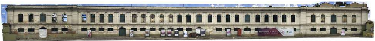
Figura 89: Fachada actual edificio "La Flauta" Fuente: Fotomontaje fotografías Consultoría NVP arquitectos 2018
