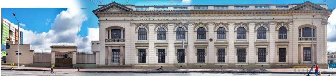
Figura 69: Fotografía fachada norte.
