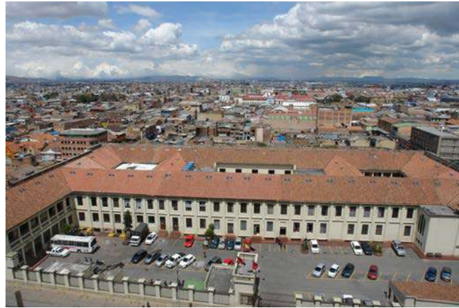
Figuras 144 y 145: Cubierta interior y exterior.
