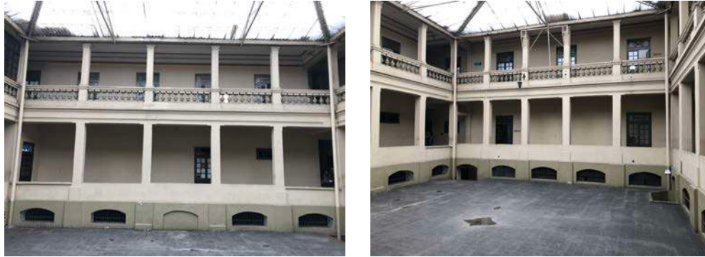
Figuras 28 y 29: Fotografías Patio Sur – Fachada Occidental, Fachada Sur. Año 2018 Fuente: Consultoría NVP arquitectos 2018.
