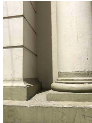
Figuras 104 y 105: Muros interior y en fachada con morteros de cemento
