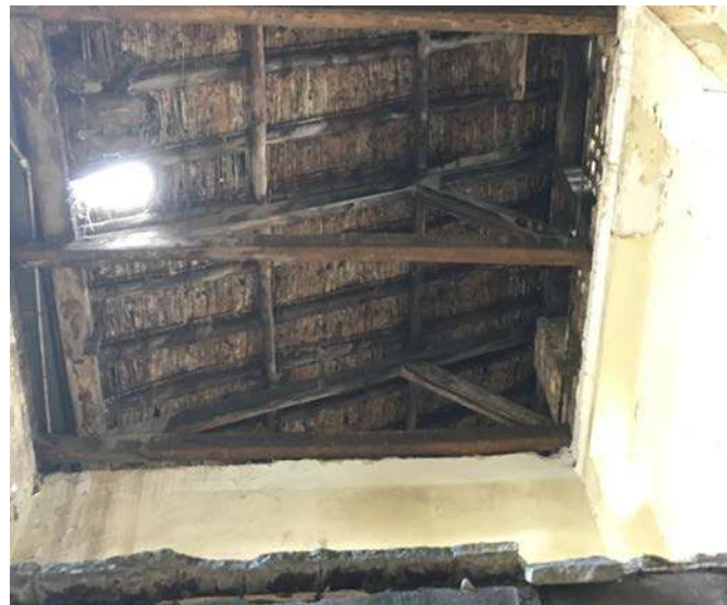
Figura 133: Entramado de cubierta edificio "La Flauta" Fuente: Fotografía consultoría NVP arquitectos 2018.
