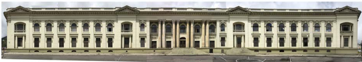
Figura 61: Fotografía fachada occidental.
