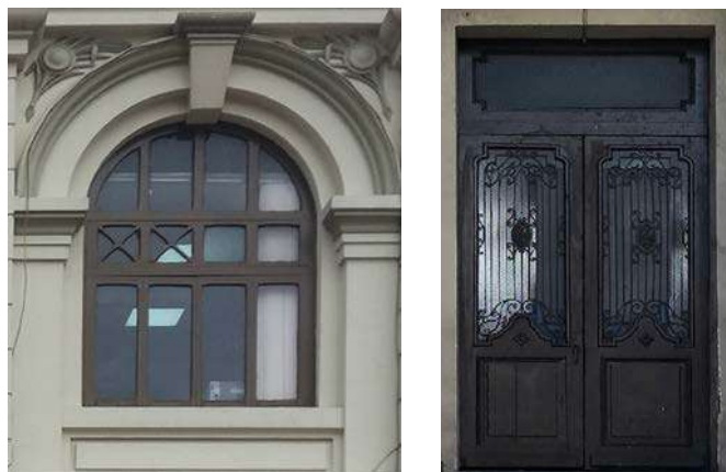
Figuras 124 y 125: Carpintería en madera – Ventana fachada Calle 15- Puerta Principal Calle 9. Fuente: Fotografías consultoría NVP arquitectos 2018.
