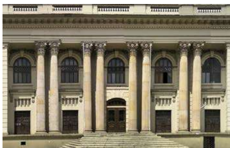
Figuras 107 y 108: Pilastras en piedra en fachada occidental. Cornisa en concreto armado. Fuente: Fotografías Consultoría NVP arquitectos 2018.
