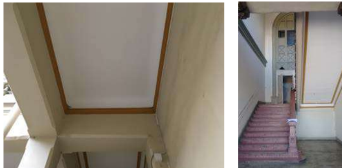
Figuras 118 y 119: Tramos de cornisas Fuente: Fotografías consultoría NVP arquitectos 2018.
