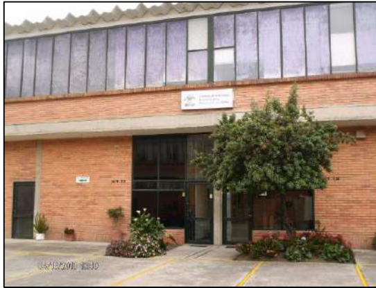
Figura 1: Fachada del actual Laboratorio de Control Ambiental del IDEAM. Fuente: Fotografía de la página del IDEAM http://www.ideam.gov.co/web/agua/laboratorio-calidad-ambiental
