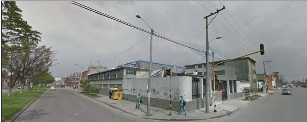
Figura 2: Predio de la Calle 12 # 42 B – 44 (esquinero). Cruce de la Calle 12 (derecha) con la Carrera 43 (izquierda). Fuente: Elaboración propia a partir de la fotografía STREET VIEW de Bogotá en http://maps.google.es/
