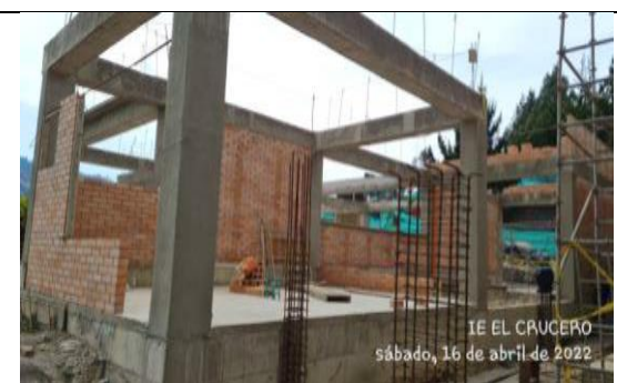
Imagen 6. Fachada principal bloque 4
