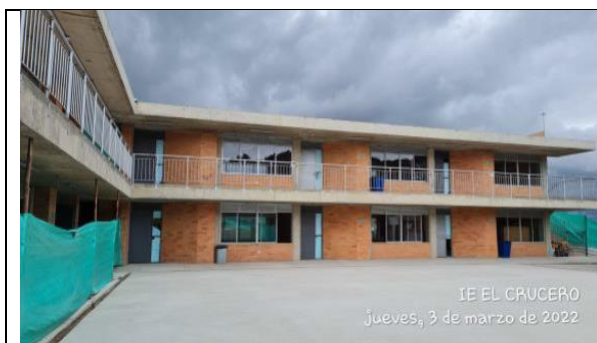
Imagen 1. Fachada Principal Bloque 1
