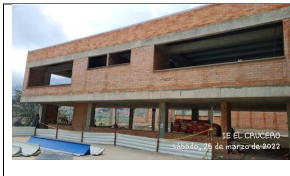
Imagen 3. Fachada Principal Bloque 3
