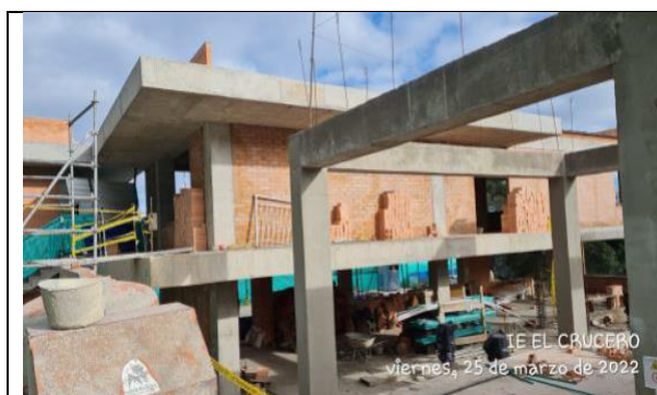
Imagen 5. Fachada Principal interior bloque 3
