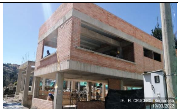
Imagen 4. Fachada Posterior Bloque 3
