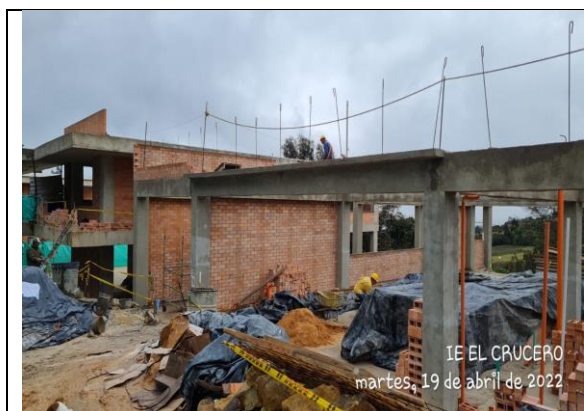
Imagen 7. Fachada Principal Bloques 3 y 4
