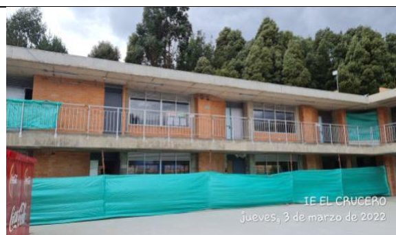
Imagen 2. Fachada principal bloque 2
