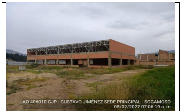
Imagen 5. Fachada Principal bloque C
