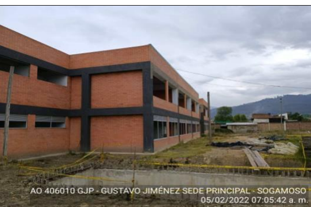
Imagen 4. Fachada Posterior Bloque B
