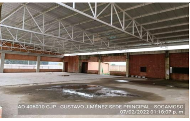
Imagen 6. Vista interior bloque C
