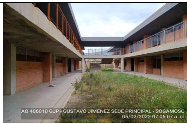
Imagen 2. Fachada Interior bloque AyB
