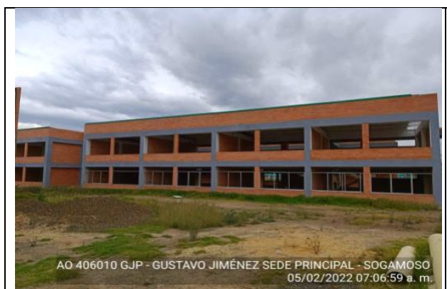
Imagen 3. Fachada Posterior Bloque A
