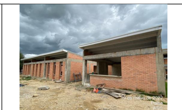
Imagen 10. Fachada Posterior Bloque D
