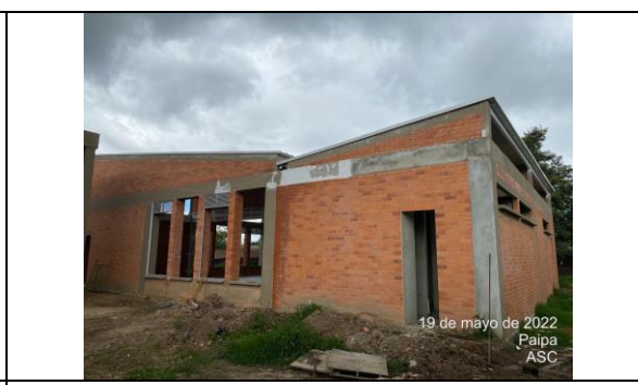
Imagen 12. Fachada Posterior Bloque E
