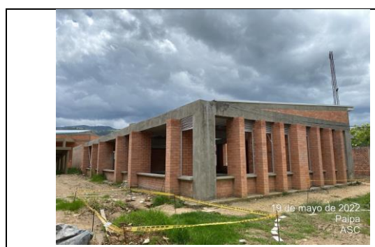
Imagen 9. Fachada Principal Bloque D
