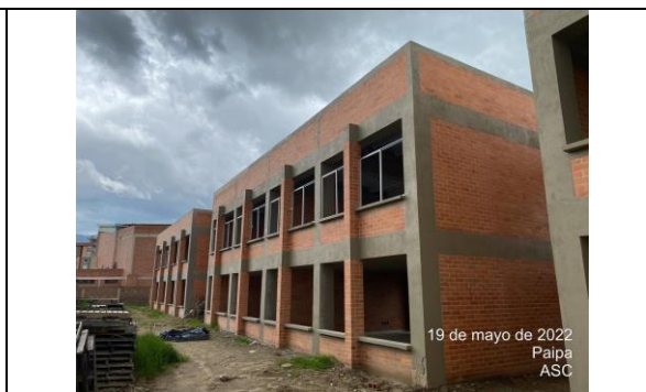
Imagen 8. Fachada Posterior Bloque C2
