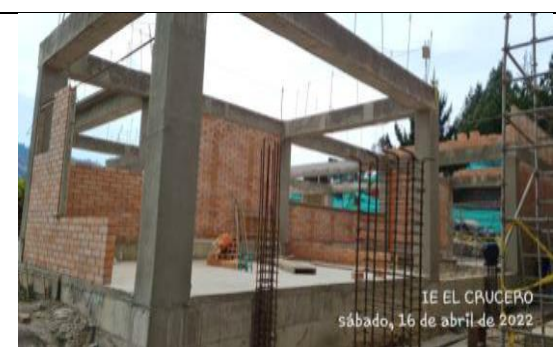
Imagen 6. Fachada principal bloque 4
