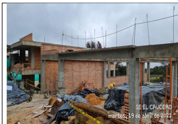
Imagen 7. Fachada Principal Bloques 3 y 4
