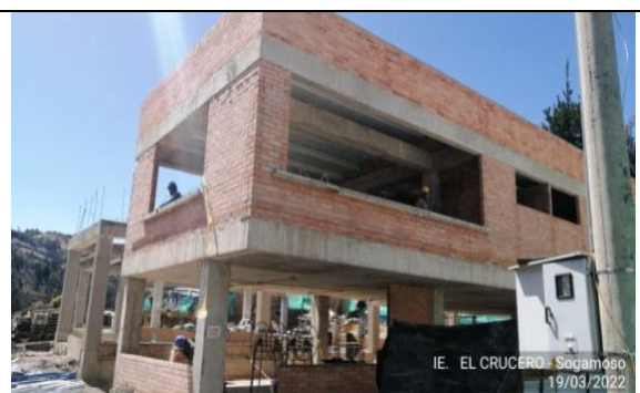
Imagen 4. Fachada Posterior Bloque 3
