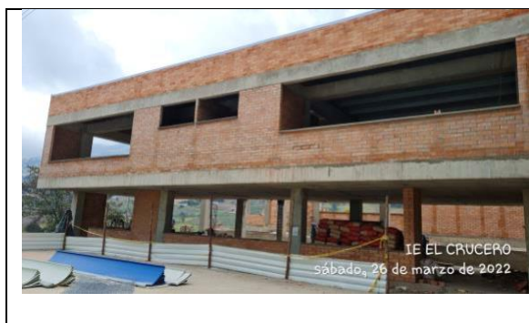
Imagen 3. Fachada Principal Bloque 3
