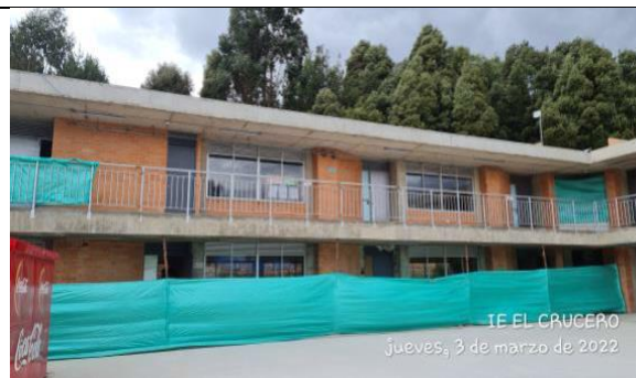
Imagen 2. Fachada principal bloque 2
