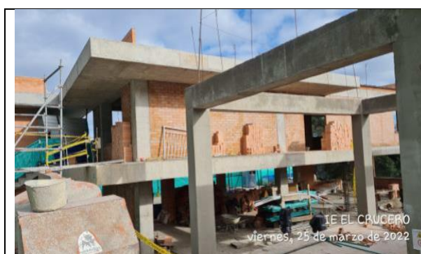
Imagen 5. Fachada Principal interior bloque 3
