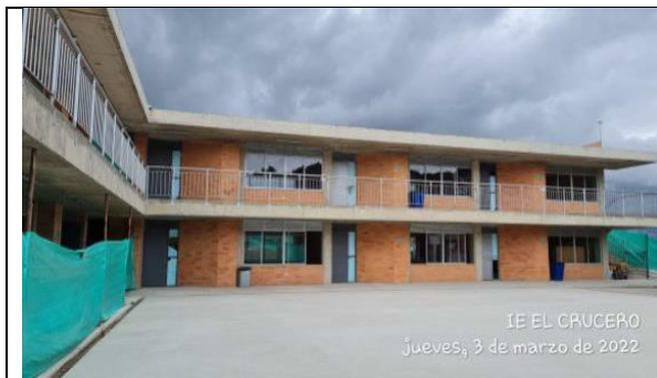
Imagen 1. Fachada Principal Bloque 1
